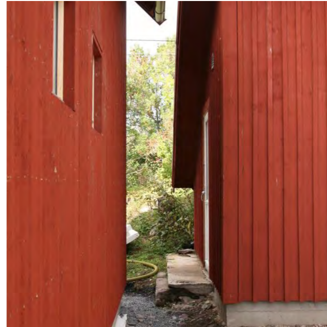
Einfaldar timburklæðningar, málaðar
