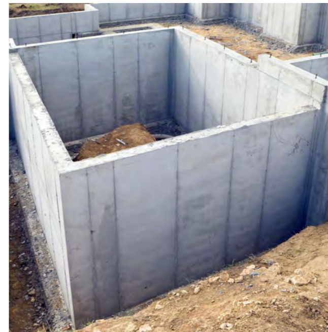
Í einhverjum tilfellum er viðeigandi að steypa grunna eða nota steypdir einingar. Sérstaklega þar sem jarðvegur er mjög blautur eða hús stendur í miklum halla.
